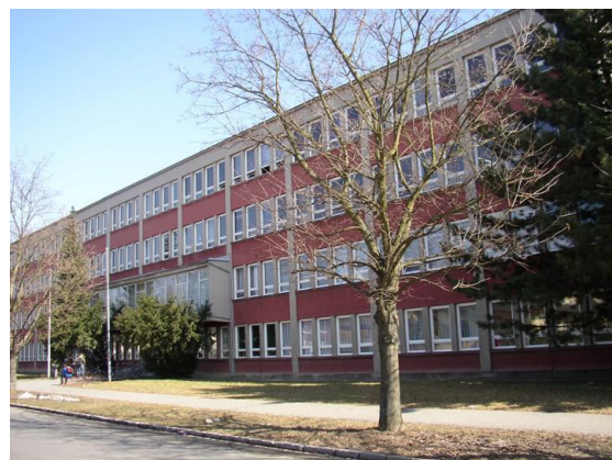
Budova školy Gen. Krátkého 30, 787 01 Šumperk
