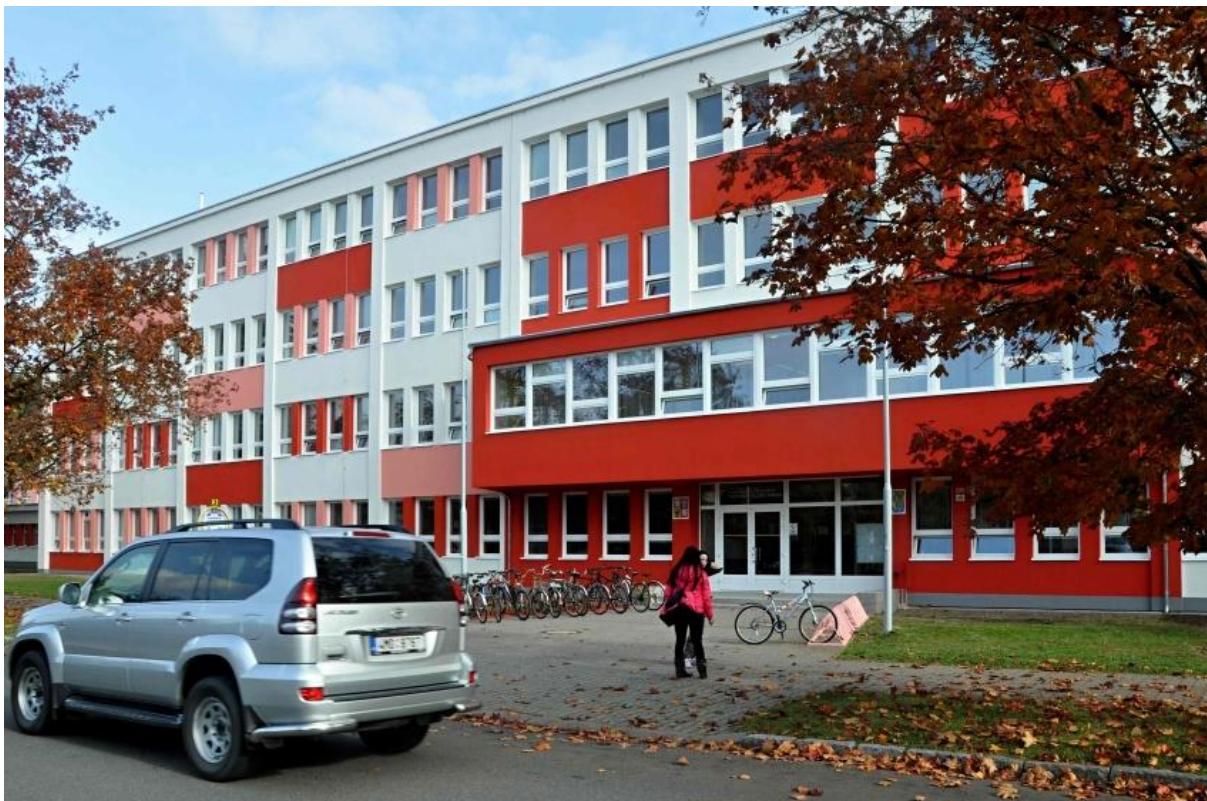
Budova školy Gen. Krátkého 30, 787 01 Šumperk
